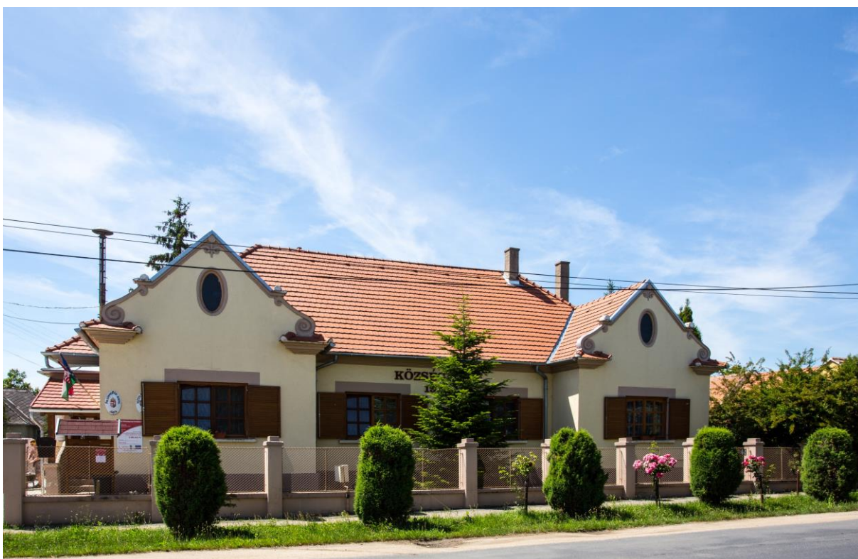
Felújított ház Ófalu településrészében, hagyományos cseréptetővel, világos homlokzattal, eredeti ablakokkal, spalettával redőny helyett (!) a jellemző sötétebb lábazattal. A homlokzat eredeti díszítő elemei megőrzésre kerültek.
